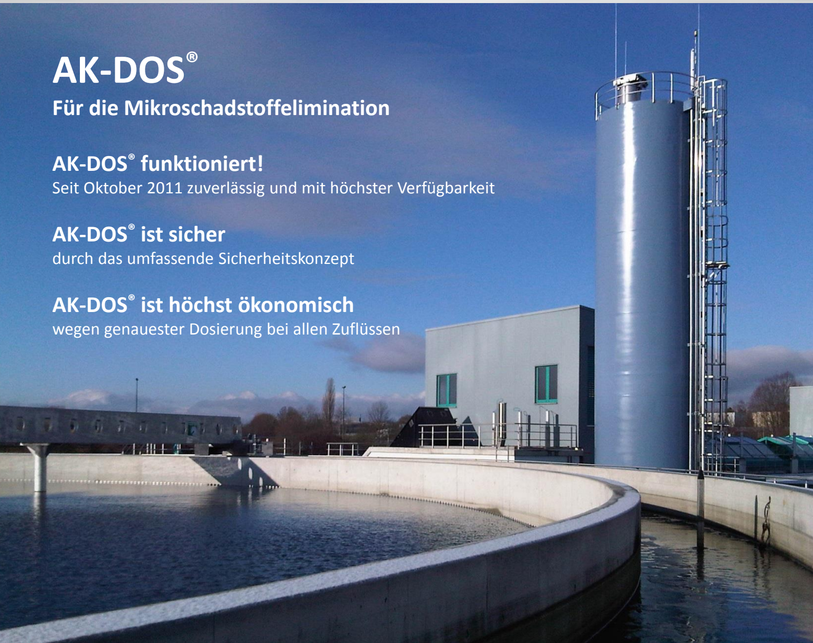
Foto: Zweckverband Kläranlage Böblingen-Sindelfingen
